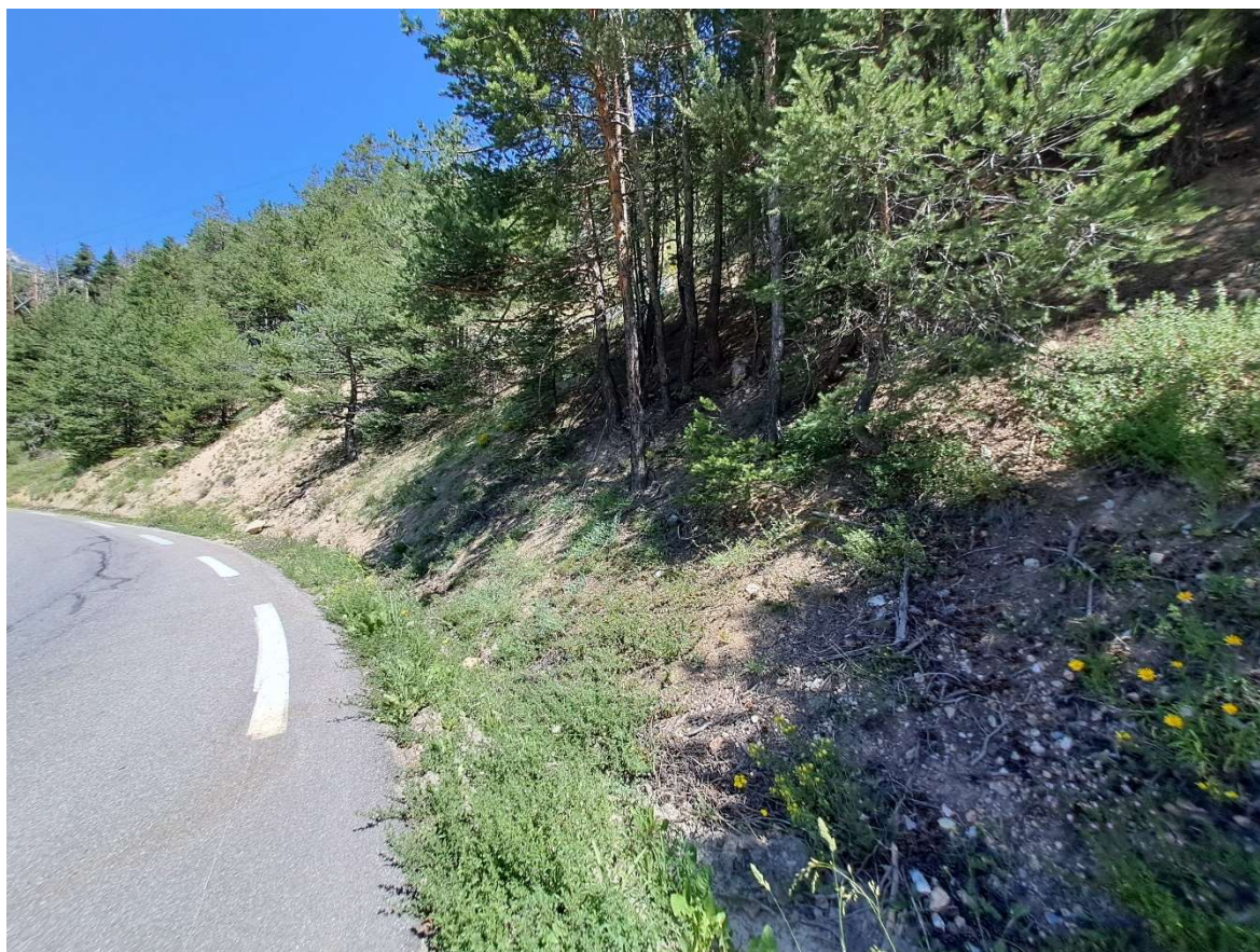
Figure 17 : Fossé en pied de talus côté amont – section 3 (Source : SEGIC, visite du site du 11/07/2023)
