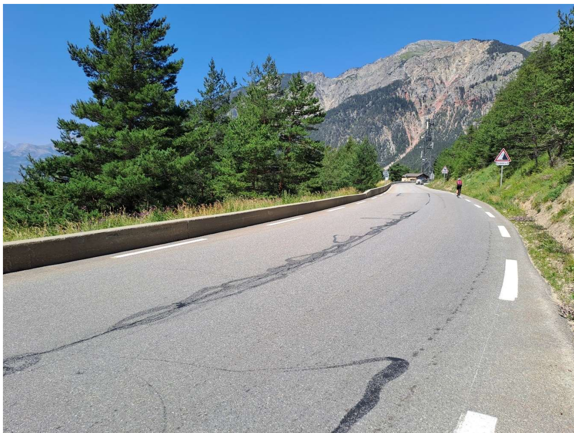
Figure 15 : GBA pleine en partie basse côté aval – section 3 (Source : SEGIC, visite du site du 11/07/2023)
