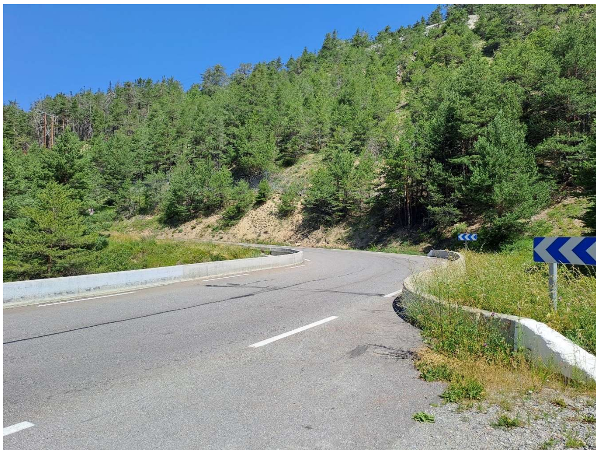
Figure 19 : GBA pleine côté aval – section 4 (Source : SEGIC, visite du site du 11/07/2023)
