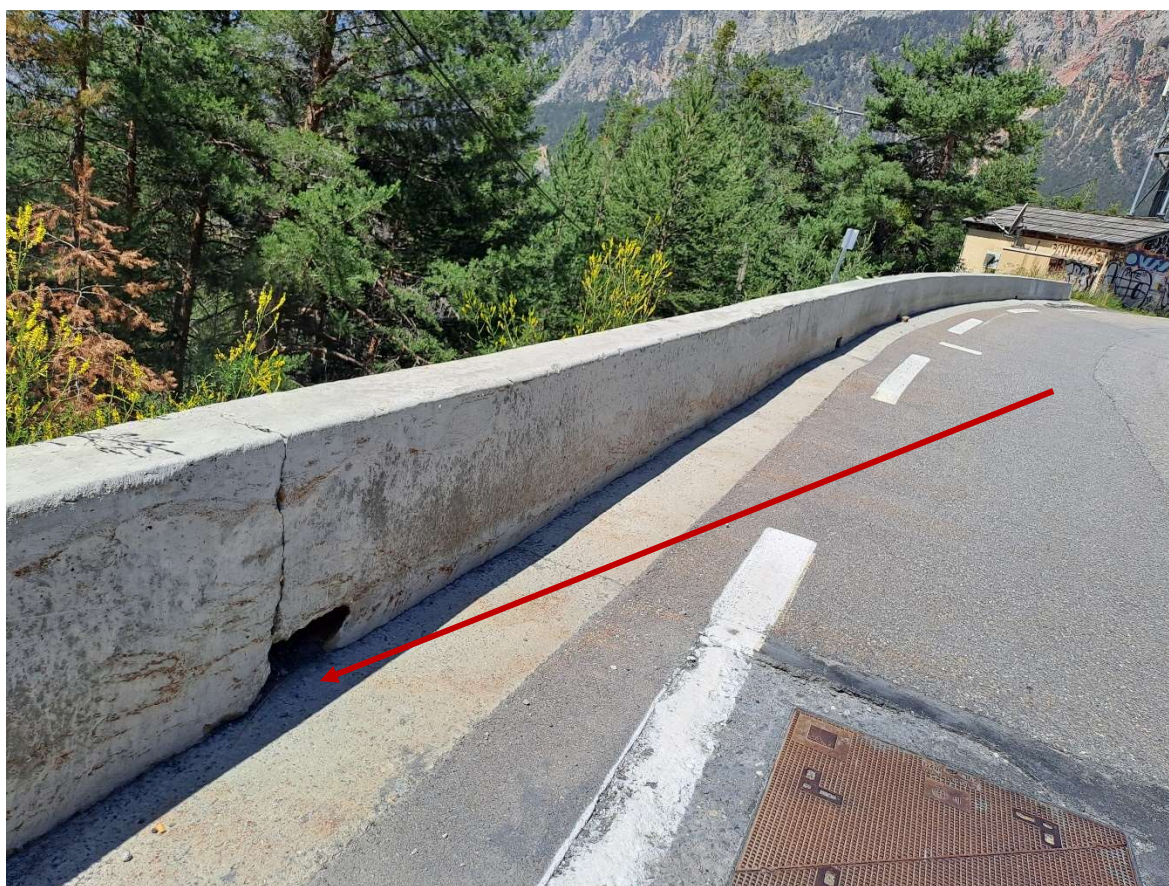
Figure 14 : Réservations de passage d'eau en partie haute côté aval – section 2 (Source : SEGIC, visite du site du 11/07/2023)
