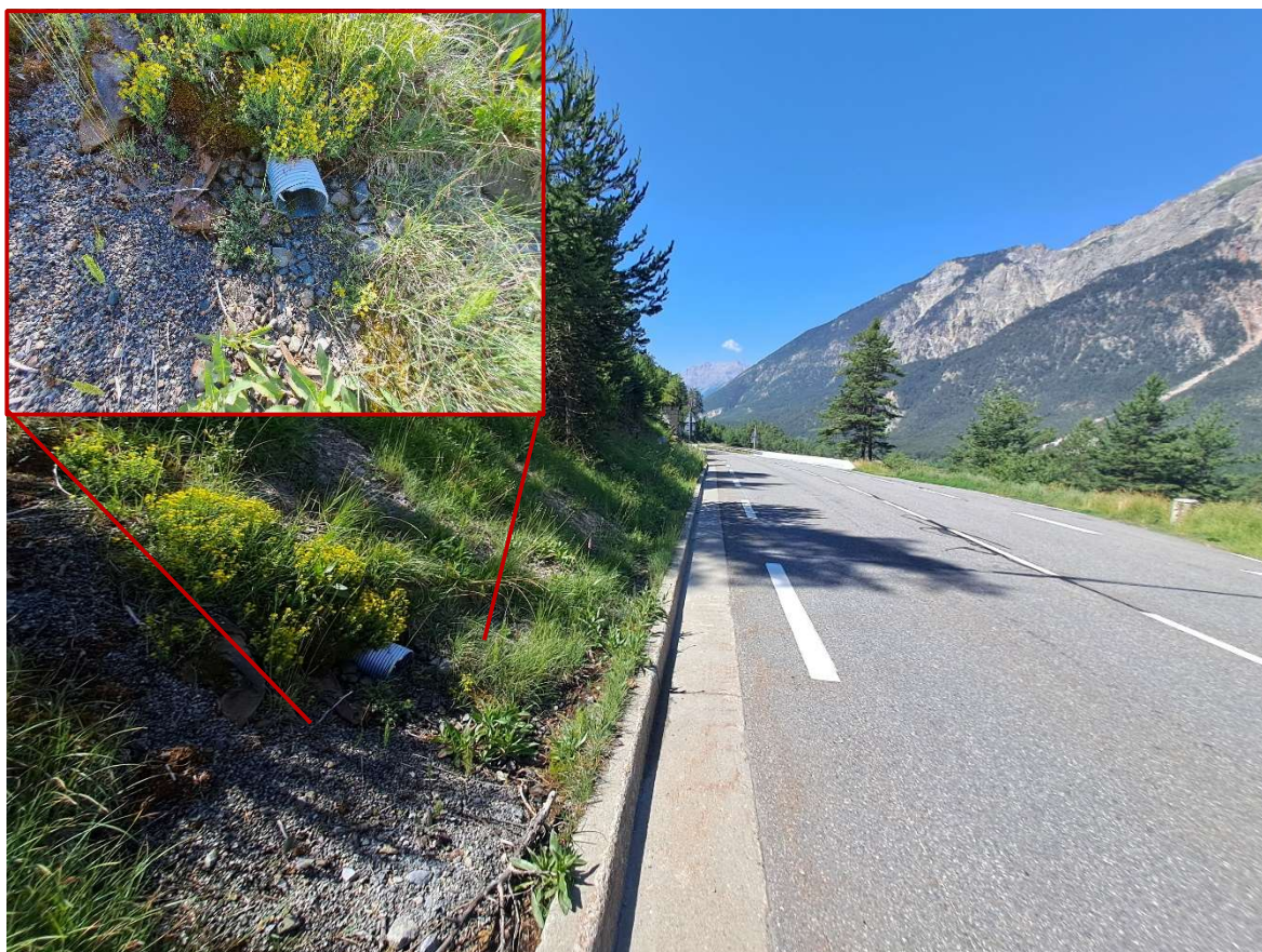
Figure 21 : Caniveau béton et drain annelé côté amont – section 6 (Source : SEGIC, visite du site du 11/07/2023)
