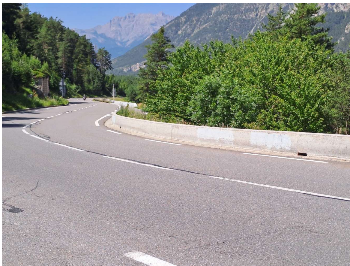
Figure 20 : Réservations de passage d'eau côté aval – section 5 (Source : SEGIC, visite du site du 11/07/2023)
